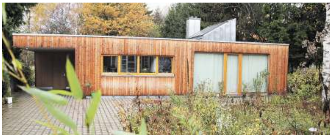
Die „Holzbox“ trägt ihre Heizungsanlage auf dem Dach.
